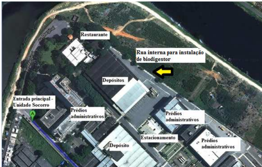
Figura 5.2 – Vista área de parte da Unidade Socorro, com detalhe para área de instalação do biodigestor
